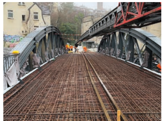
03 Bei der Renovierung wurden zahlreiche Stahlprofile getauscht und ergänzt.
