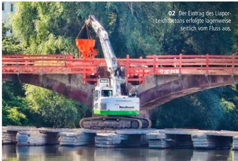
02 Der Eintrag des Liapor-Leichtbetons erfolgte lagenweise seitlich vom Fluss aus.
