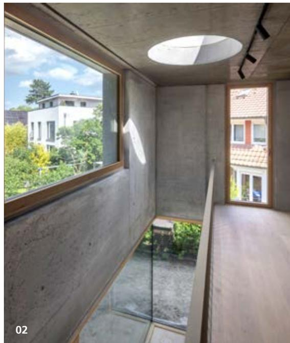
**01** Bei dem Wohnhaus verschmilzt die Tragstruktur mit der Dämmung zu einem monolithischen System.
