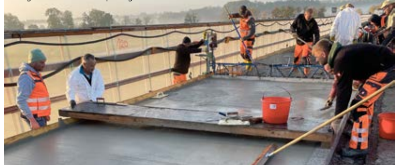
01 Brückenkappen aus Leichtbeton sorgen für Gewichtseinsparungen.
