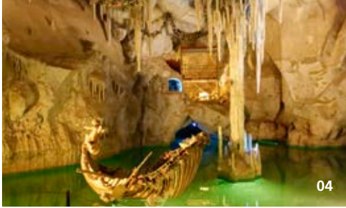
04 Die Ziegelgewölbe der Venusgrotte bei Schloss Linderhof wurden stufenförmig mit Liapor-Leichtbeton gedämmt und stabilisiert.
