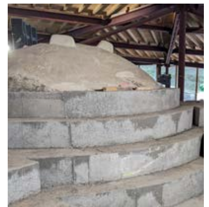
03 Der Liapor-Leichtbeton dämmt und stabilisiert die gesamte Dachkonstruktion.
